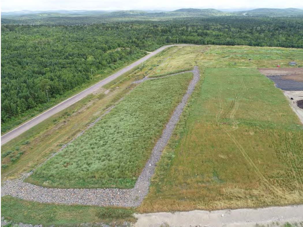
Photo 2 : Vue des cellules d'enfouissement revêtues d'une couverture finale (2023).
