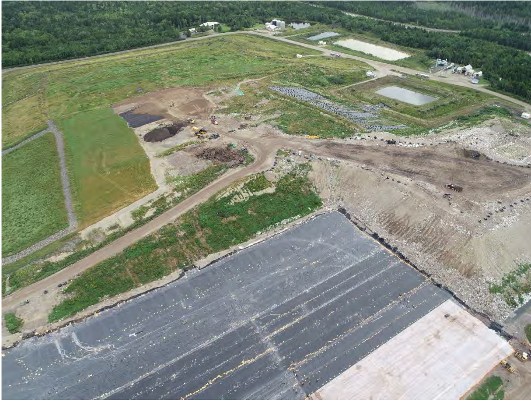
Photo 1 : Vue des cellules d'enfouissement recouvertes et actives (2023).
